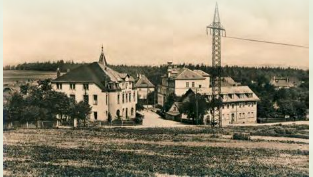
Ansicht Unterweißig mit Gasthof Schule und ehemaligem Konsum
