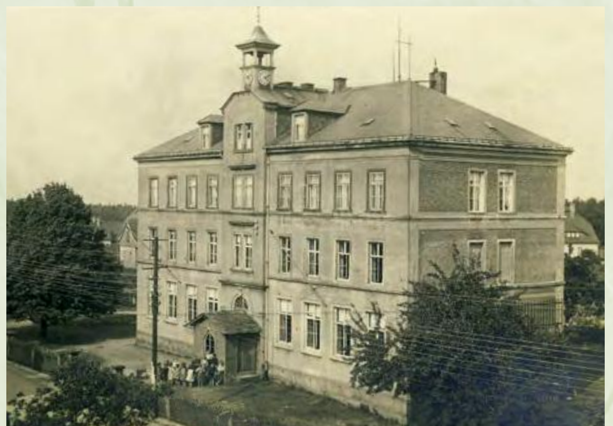
Ansicht der Schule mit aufgesetzten Stockwerk um 1925
