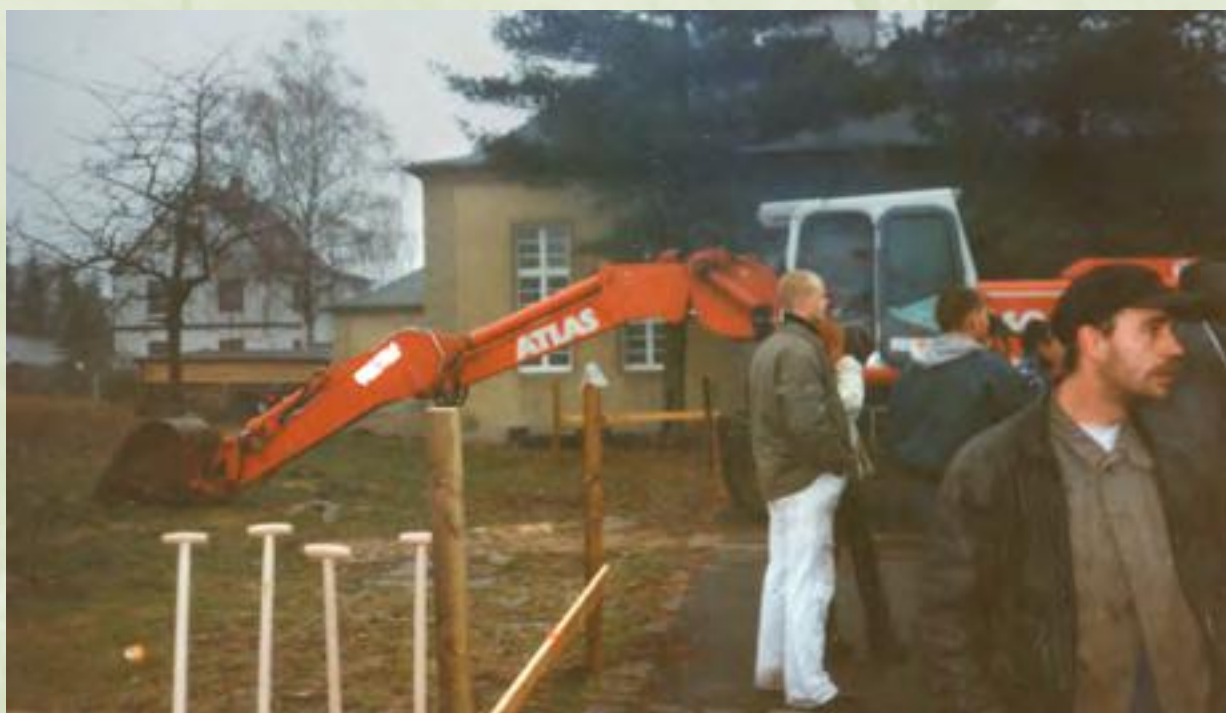
Erster Spatenstich am 22.11.97
