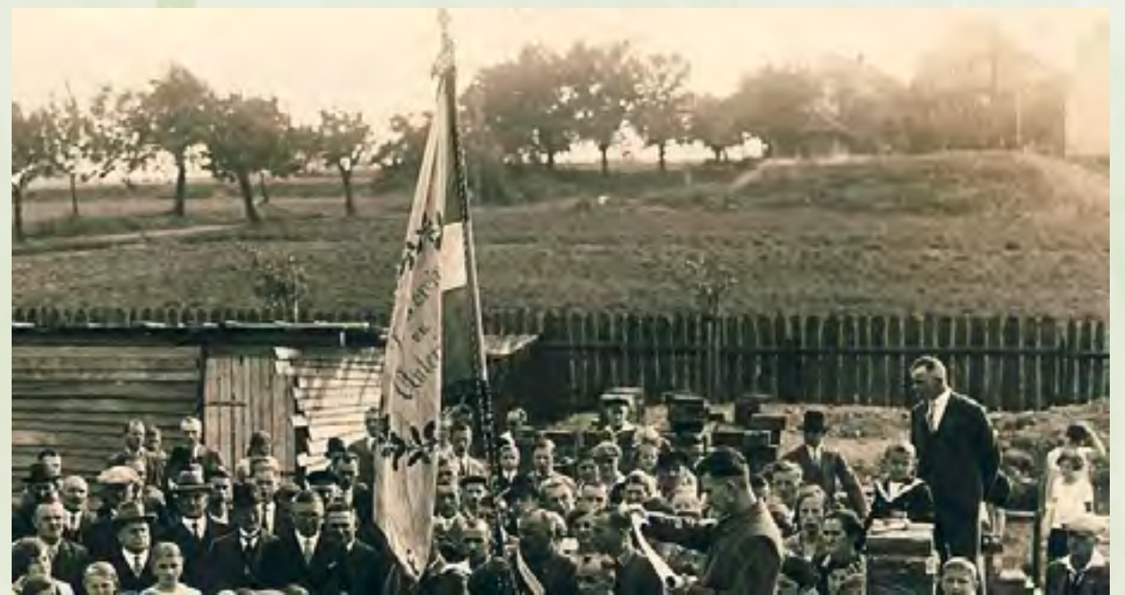
Auf dem Bild von der Grundsteinlegung zur Turnhalle im Jahr 1919 ist der historische Wasserbehälter mit dem Wasserhaus zu erkennen
